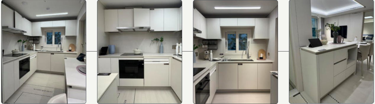
< 84A 타입 - 주방 세라믹타일 시공 사례 >
