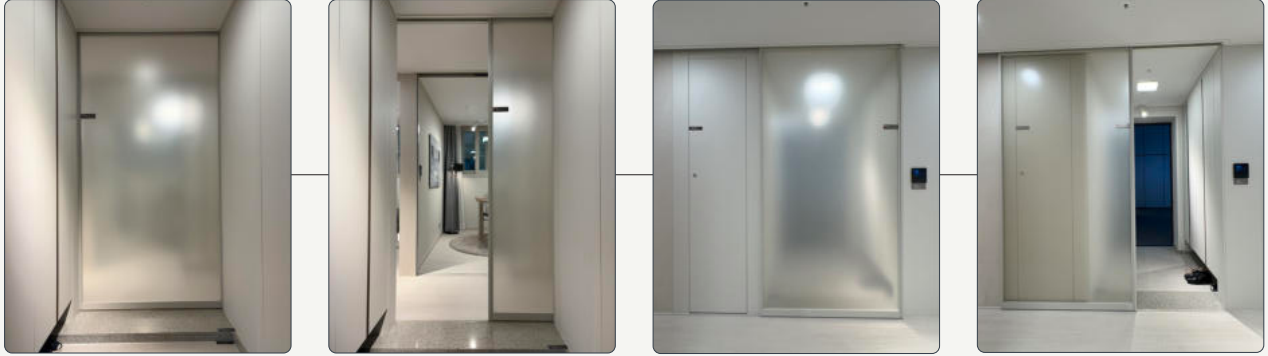
<59 타입 - 원슬라이딩도어 시공 사례>
